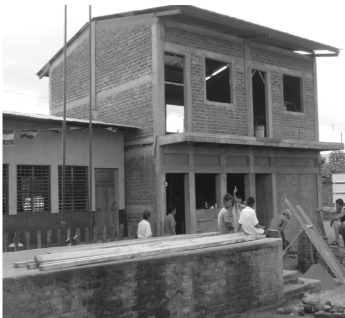
Der Bibliotheksrohbau im Oktober 2004
